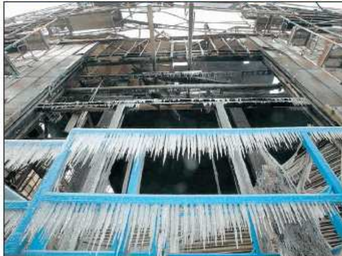
Das „Energetikum“-Gebäude in der Rheinlandstraße in Ludwigsburg brannte in der Nacht auf den gestrigen Mittwoch komplett nieder. Erst am Morgen war das ganze Ausmaß zu sehen. Fotos: Martin Kalb
